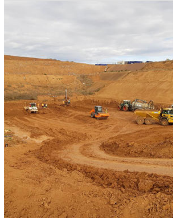
Mise en place de l'argile
