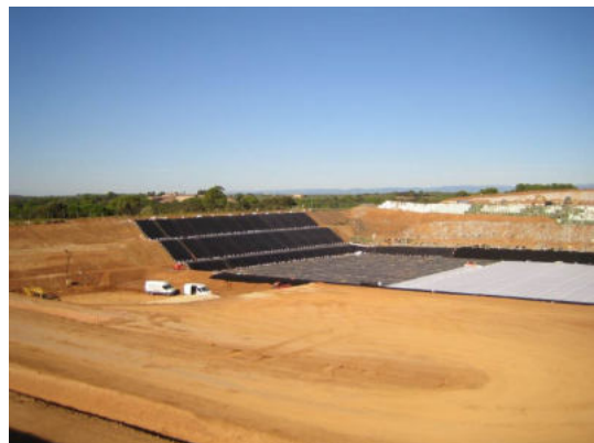
Etanchéité des parois
