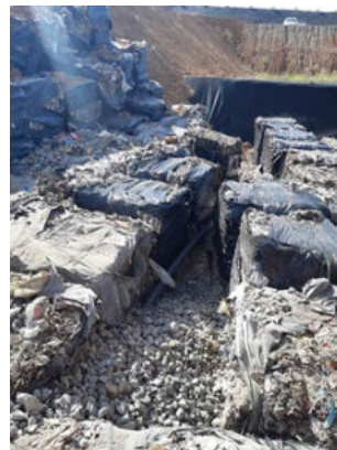
Tranchée biogaz à l'avancée
