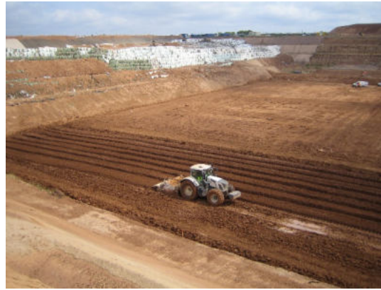
Mise en place de l'argile
